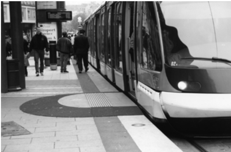
Felső kép: Villamosmegálló peron kialakítása: az ajtó helye egyértelműen jelzett szintbeli kiemeléssel, színbeli eltéréssel, anyagbeli váltással. Picture above: Tramway stop. The door location is unambiguous due to slight level difference, the contrasts and to the change in surface materials.
